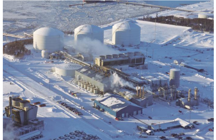
Kenai LNG Plant (photo courtesy: ConocoPhillips)
